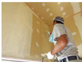
壁・天井は石膏ボードを貼り、仕上げとしてリバースコート(珪藻土仕上げ材)を塗ります
