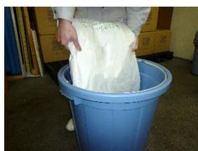
④攪拌しながら「リバースコート専用珪藻土」を5回程度に分けて入れます。攪拌しながら分けて入れることで、珪藻土の沈殿が軽減され、なめらかさが出て施工性が向上します。
