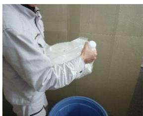
①リバースコート専用混合液」をよく揉み込み混ぜ合わせてください。糊の成分が沈殿していますので、手でよく揉んで混ぜ合わせます。
