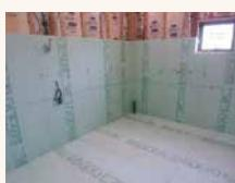
床・壁・天井に断熱材を入れ
