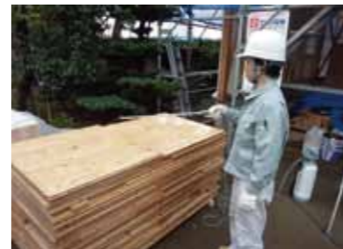
合板に噴霧する際は、初めに重ねた状態で側面に噴霧した後、1枚ずつ両面に噴霧します。
