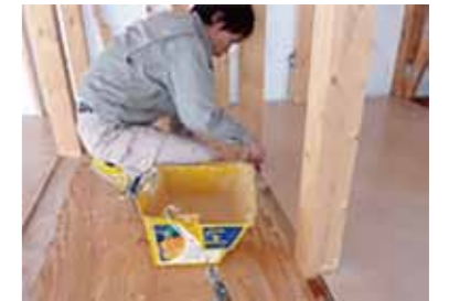
断面からも有害化学物質が発散しますので、刷毛等を使って塗るといっそう効果的です。
