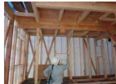
先端部分が伸縮できる噴霧器を使うと効率よく作業できます。
