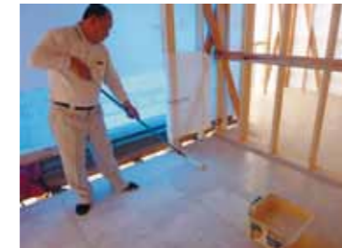
ムラができないよう、一定の方向に向けて塗布してください。
