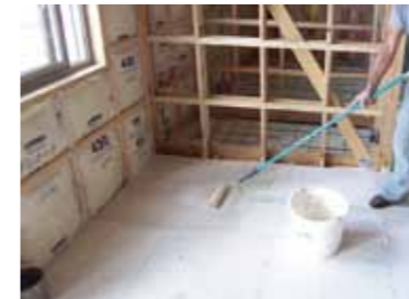
フローリング等の床材張り付け前に塗布します。
