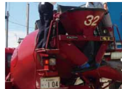
基礎コンクリート工事 P.32
