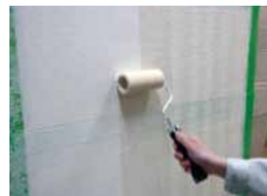
塗装用下地クロスを使う場合は種類に応じて塗布回数を調整してください。目安は2~3回程度です。
