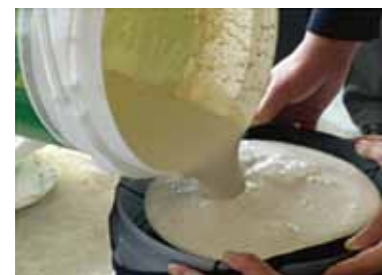
吹き付けの場合は、目の細かいストッキングなどを使ってリバースコートを1回濾してから施工します。
