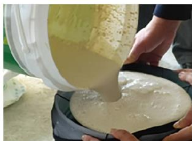
吹き付けの場合は、目の細かいストッキングなどを使ってリバースコートを1回濾してから施工します。
