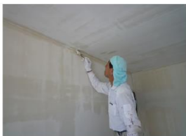
入隅や窓周りなど、ローラーが届かない箇所は先に刷毛で塗ってください。
