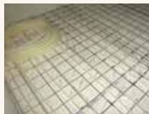
床は合板を貼り、ワイヤーマッシュを敷いて温水用パイプを固定後にモルタルを流します
