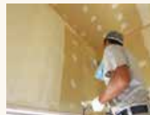
壁・天井は石膏ボードを貼り、仕上げとしてリバースコートを塗ります
