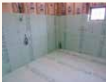
床・壁・天井に断熱材を入れます(壁は二重)
